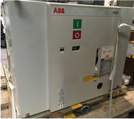
Leistungsschalter von ABB
